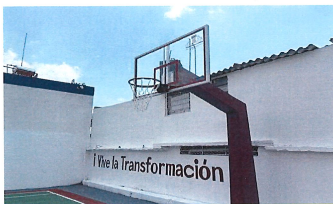
Fotografía 7. Infraestructura deportiva rehabilitada como parte de las acciones de rescate de espacios públicos.
