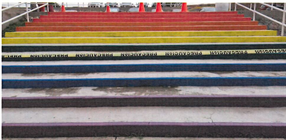
Escalera principal de la UPE
