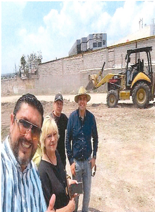
Apoyo y vinculación con el Regidor Carlos Pescador con maquinaria para emparejar terrenos de casa de Jubilados
