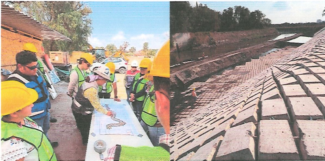
Participé en el recorrido del proyecto Federal para la restauración del Río Tula, para conocer los avances y trabajos relacionados.
