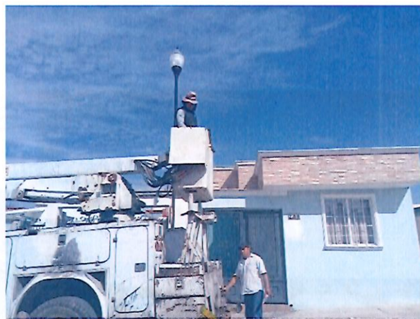
Colocación del alumbrado
